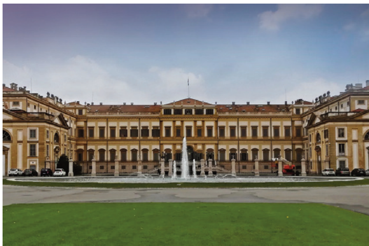
Fig.1 – Villa Reale di Monza: uno degli edifici di interesse nazionale, oggi risanato e protetto dall’umidità di risalita grazie alla tecnologia CNT
