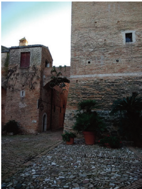
Fig.1 – Castello di San Basilio a Pisticci: uno degli edifici storici del territorio appulo-lucano, interamente risanato e protetto dall'umidità di risalita grazie alla tecnologia CNT
