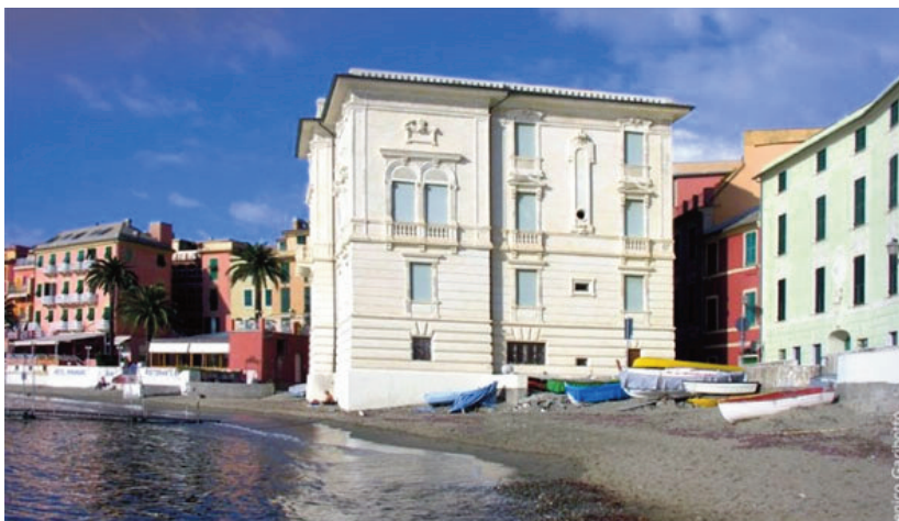
Fig.1 – Galleria Rizzi a Sestri Levante: uno degli edifici storici in territorio ligure, interamente risanato e protetto dall'umidità di risalita grazie alla tecnologia CNT
